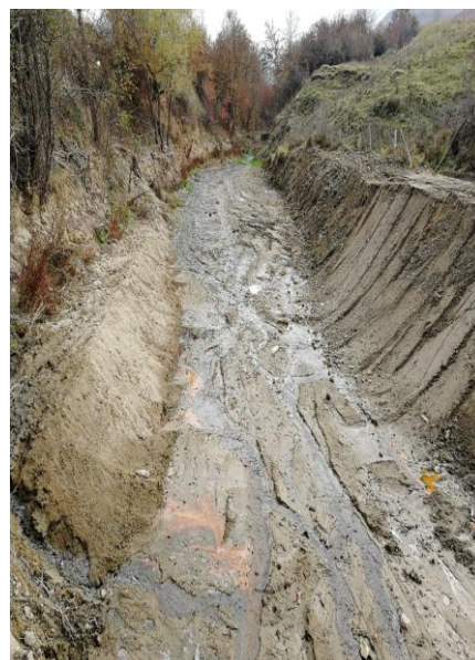
Unutrašnji deo nakon čišćenja
