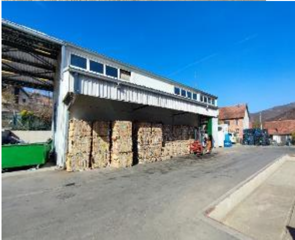
Slika 6.1.-2. Hala za reciklažu sa nadstrešnicama i telo (prijemno-otpremna zona) reciklažnog centra u Novom Pazaru, naselje Blaževo
