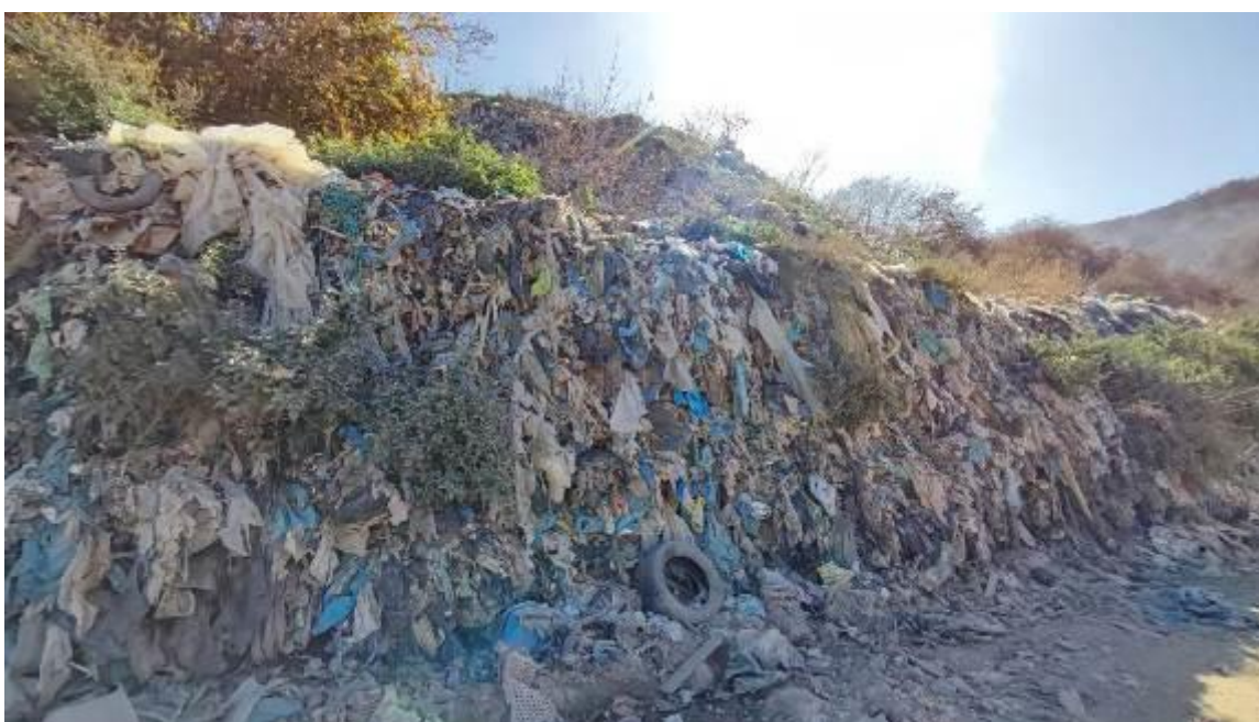
Slika 4.6-5. Sloj otpada nastao posle sabijanja i ravnanja na deponiji Golo brdo
