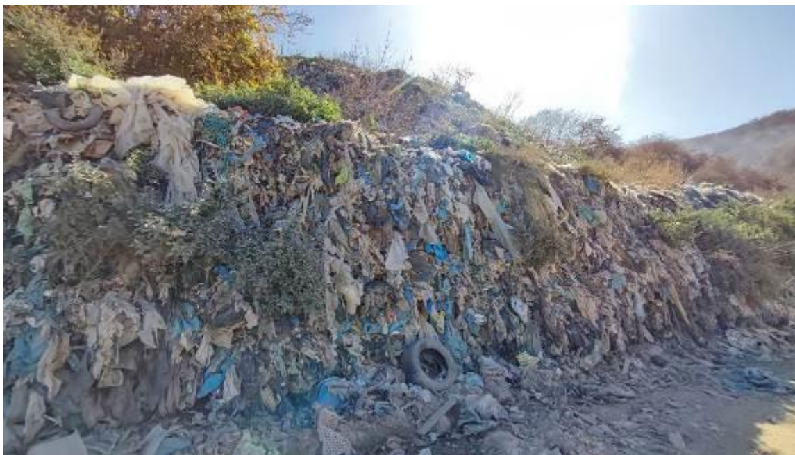
Слика 4.6-5. Слој отпада настао после сабијања и равнања на депонији Голо брдо
